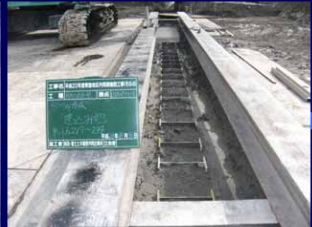
SMW造成完了
