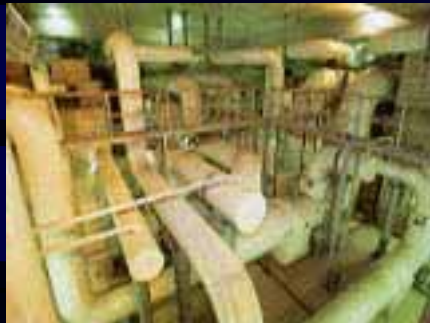
地域冷暖房導管
