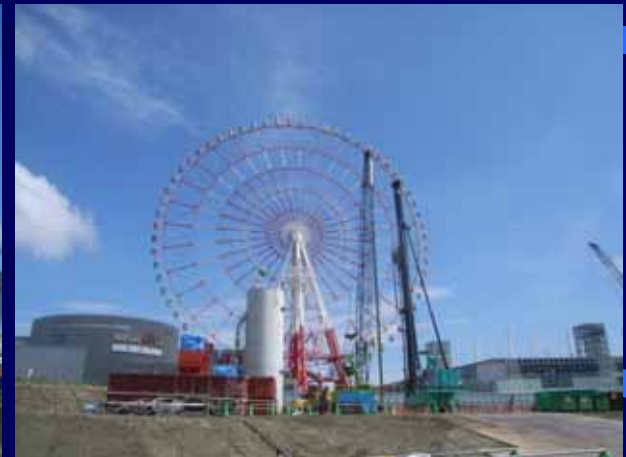
プラント設備
