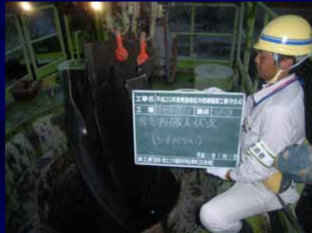
障害物(シートパイル)
