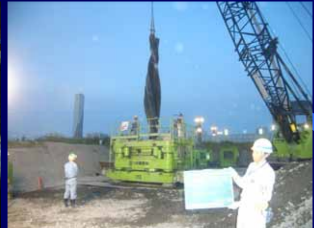
障害物(シートパイル)
