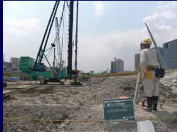
掘進時の鉛直確認
