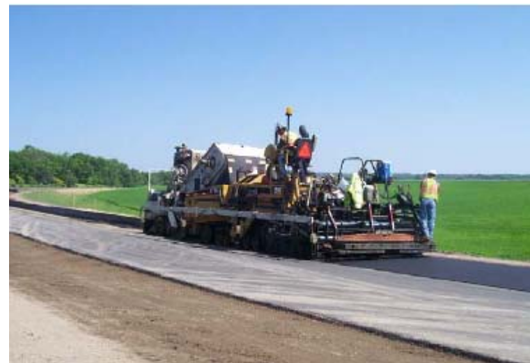
Windrow paving (速度;11.6 m/min)
