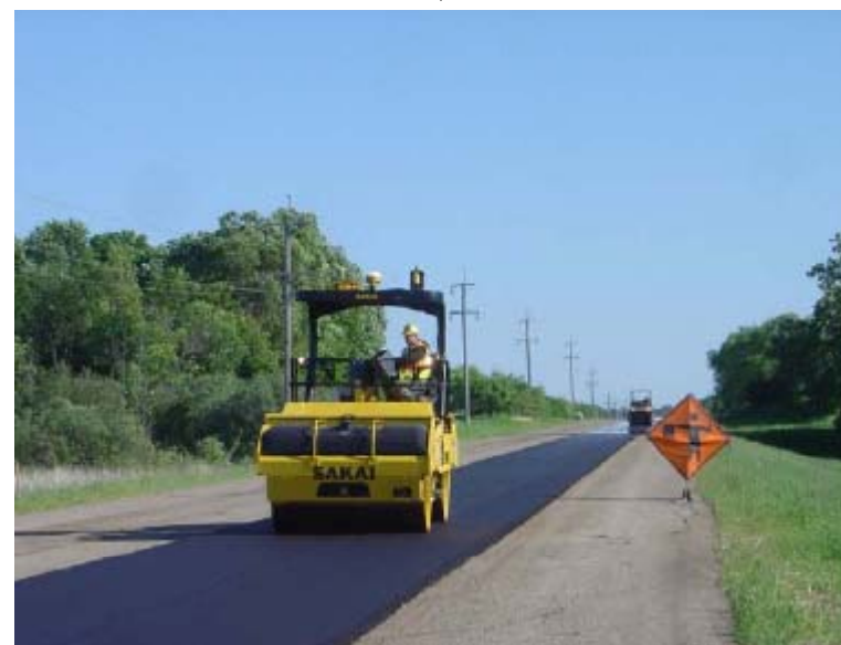
初期転圧(速度;4.8km/h)
