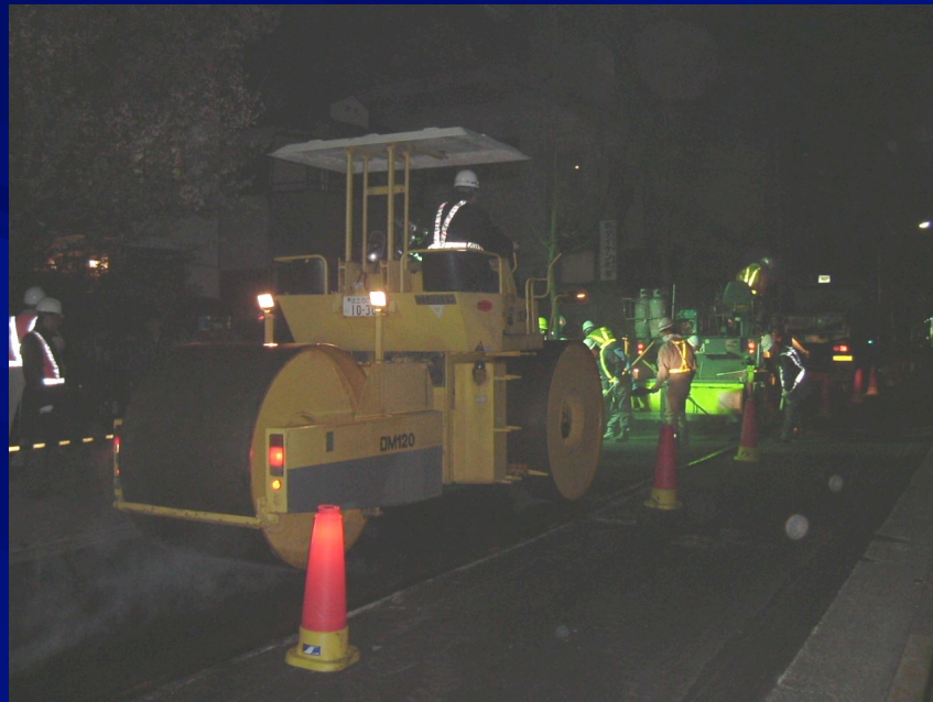
初期転圧状況
