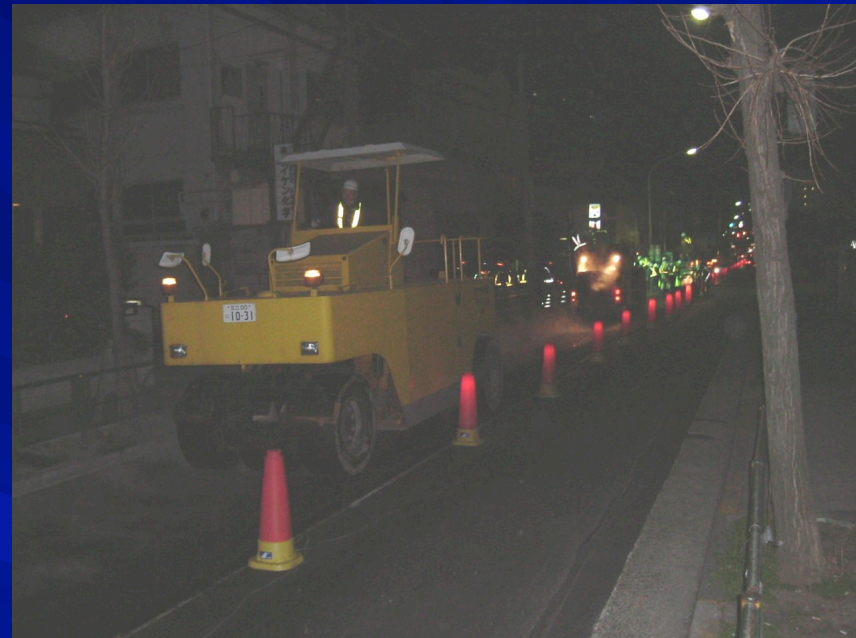
二次転圧状況
