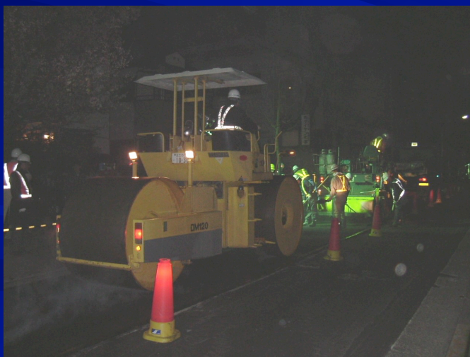
初期転圧状況
