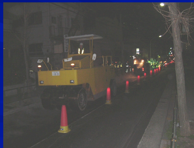
二次転圧状況
