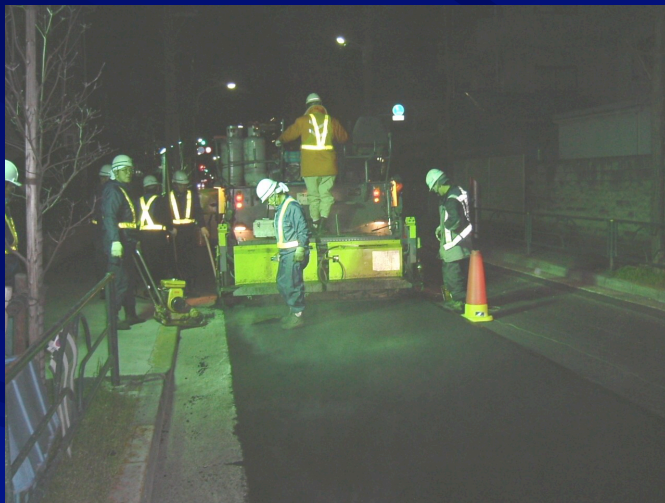
敷きならし状況
