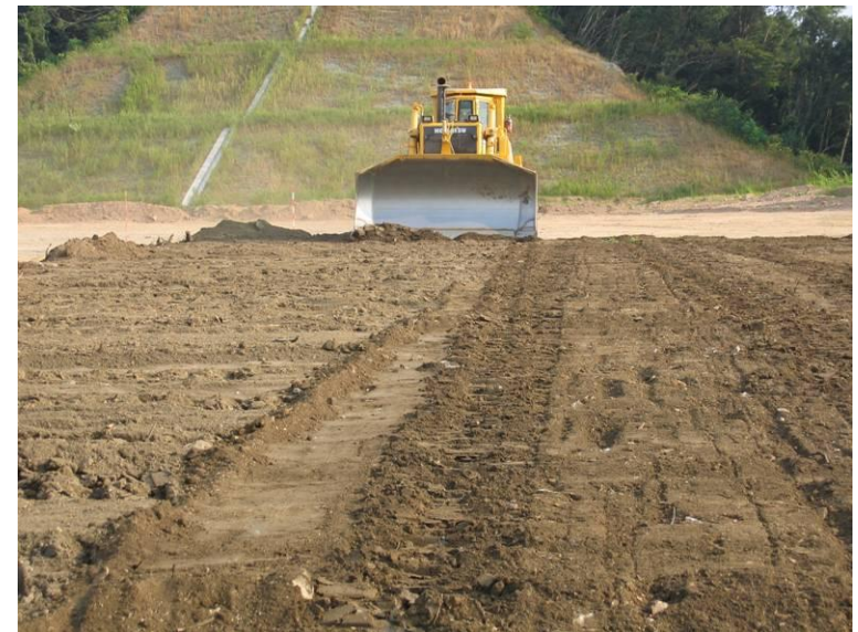
施工状況 (ローラ転圧前)
