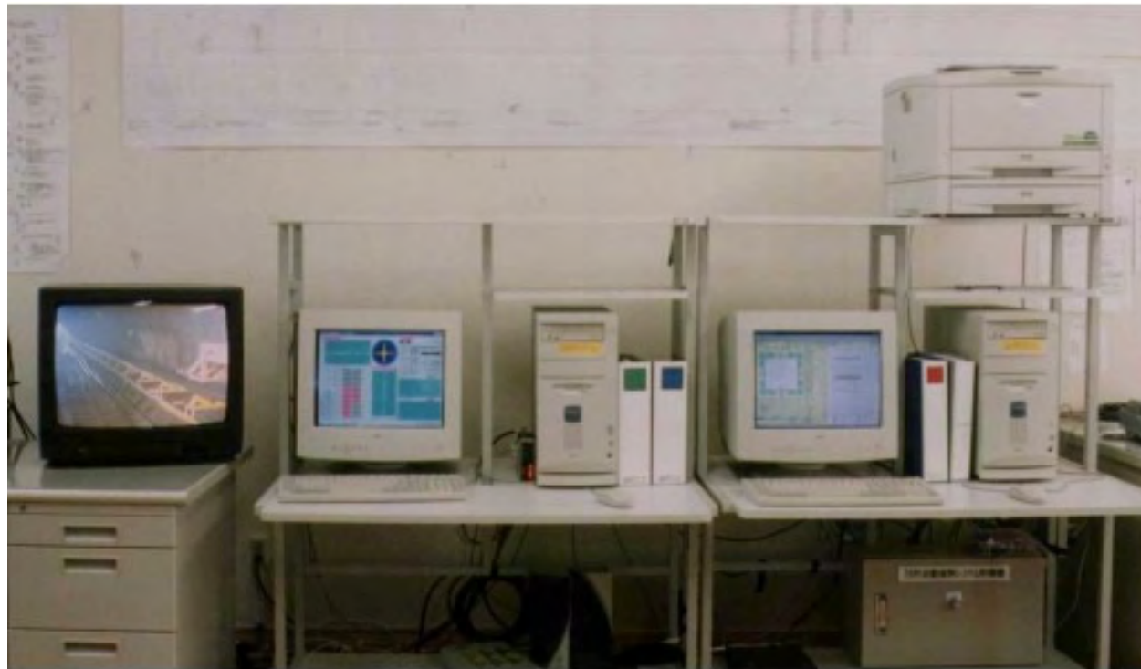
自動掘削システム稼働状況
