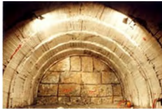
SD工法で掘削されたトンネル
