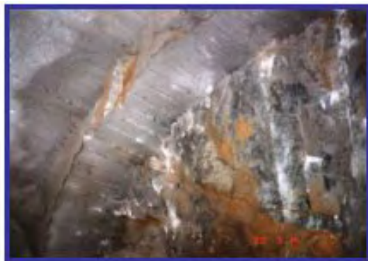
発破後の坑壁状況
