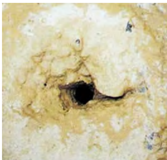
施工完了状況
