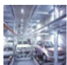
立体駐車装置
