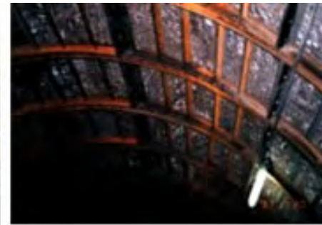
拡張後坑壁に密着したライナー
