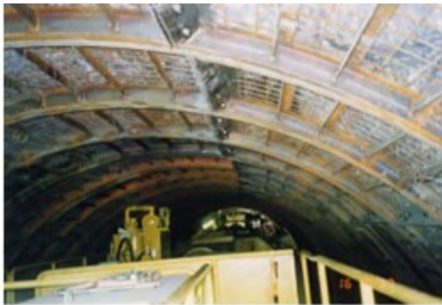
ロックライナーを支保として掘進中のTBM
