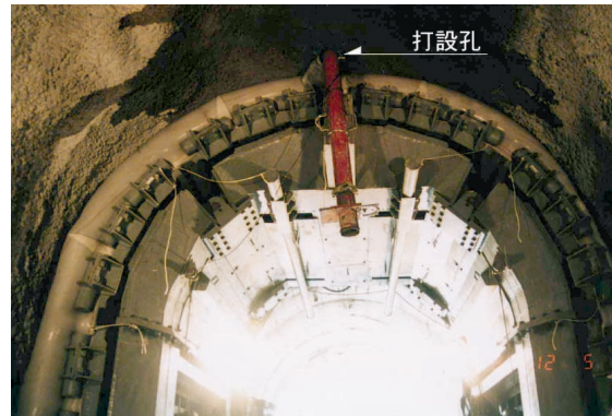
■コンクリート打設、加圧
