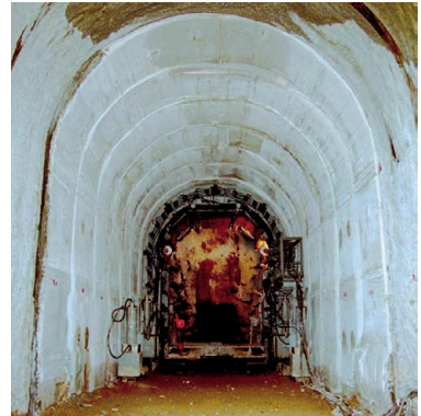
■FFC覆工出来形
