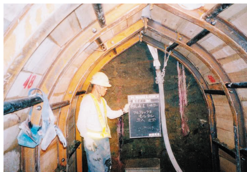
■コンクリート充填
