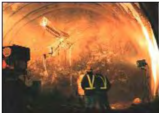
切羽での吹付状況
