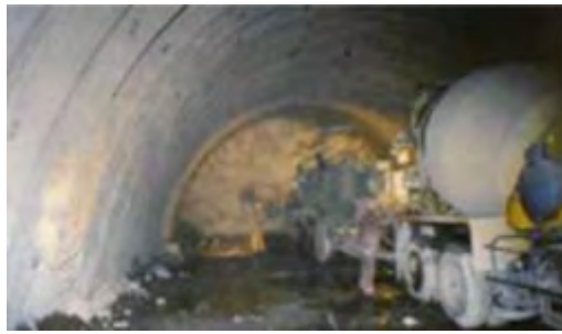
N A T Mトンネル施工現場坑内状況
