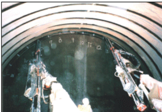
写真-4 MS先受け鋼管打設状況
