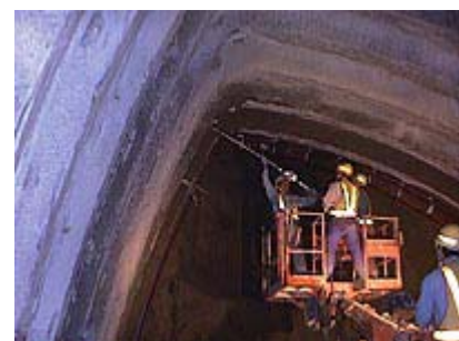
中壁工法断面ボルト
