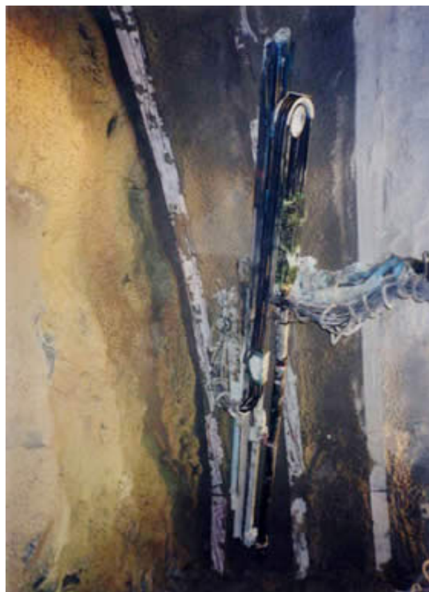
ドリルジャンボによる施工状況
