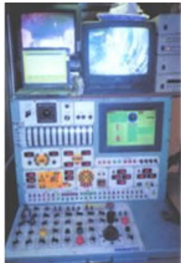
<稼働中のシステム>
