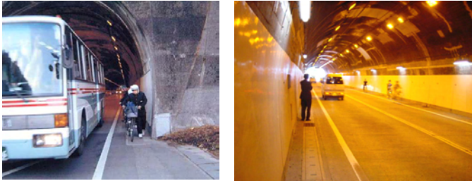
既設トンネルにおける歩道の現況
