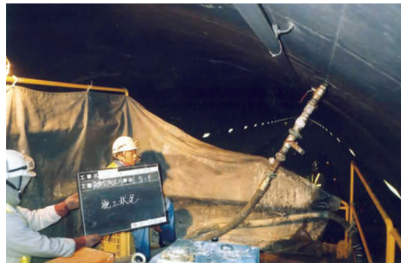
トンネル覆工背面への注入状況 Actual backfill grouting
