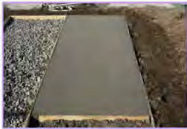
再生コンクリート打設状況（厚さ10cm）
