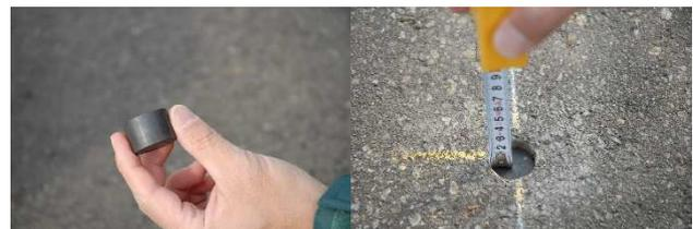
写真-4 磁気マーカ埋設状況
