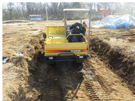
図-3 実験状況(車両沈下量測定)
