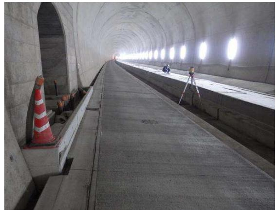
写真-9 上下線の路盤鉄筋コンクリート施工完了
