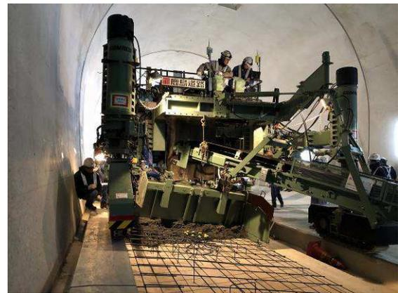
写真-5 施工時写真：正面モールド
