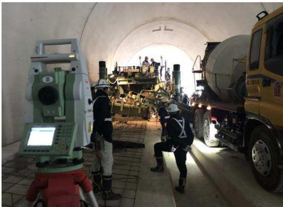
写真-8 3D制御用トータルステーション検測
