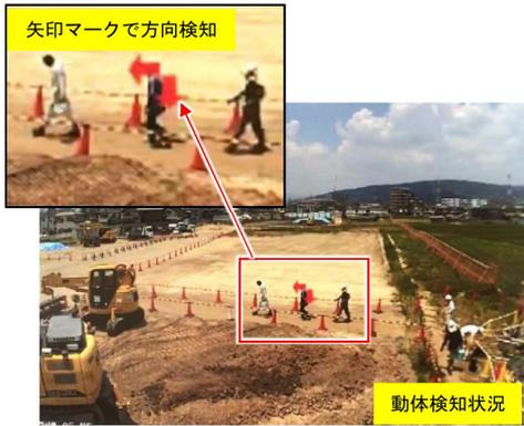
写真-1 多機能カメラによる動体検知画像
