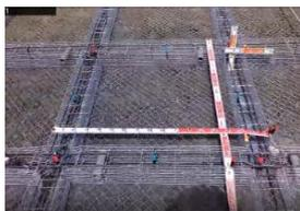
写真-10 映像による法枠検査
