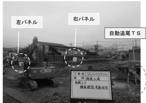
図-3 機械工場における精度確認状況
