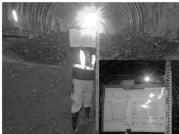
図-6 従来工法による掘削出来形管理(水系からの下がりによる確認)
