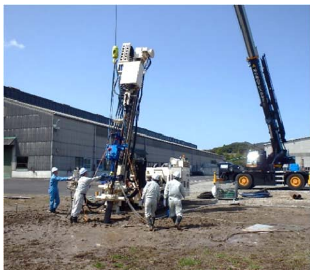
写真-4 クレーン装着型マニピュレータ
