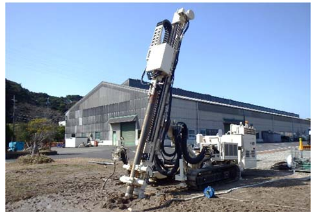
写真-2 開発施工機の全景
