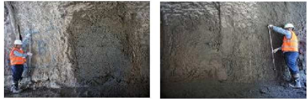
写真-4 模擬トンネルによる実吹付検証
