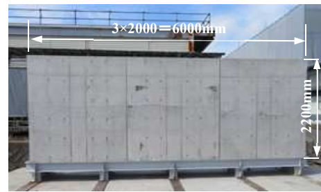
写真-7 RC 壁試験体設置状況
