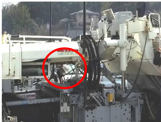
写真-1 センターライン位置でのオペレーション
