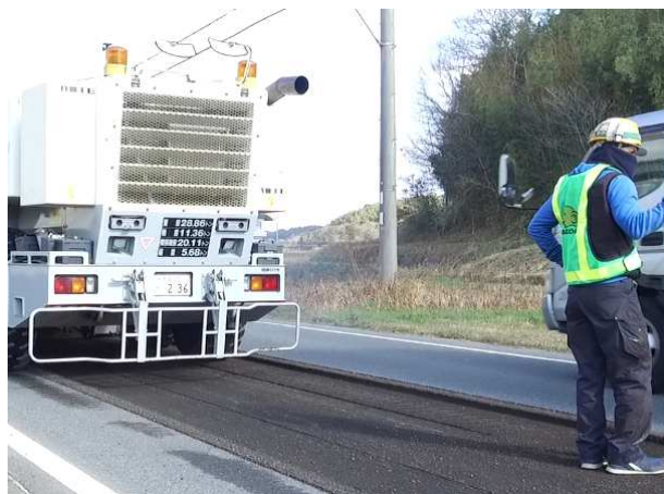
写真-2 往来する車両と切削機
