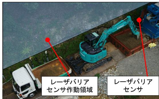
写真-6 レーザバリアセンサの作動領域
