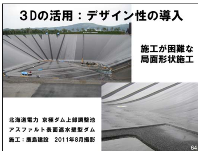
図-61 3Dデザインを活かした施工例(京極ダム)
