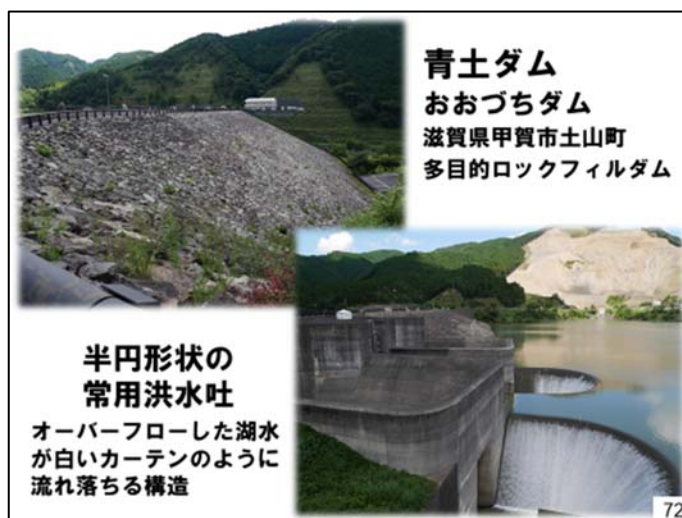
図-69 デザイン性を重視した青土ダム
